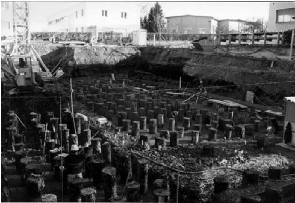
شکل 14-1 شمع های چوبی شناور مربوط به یک ساختمان صنعتی کوچک (Kemfert, 2006)
